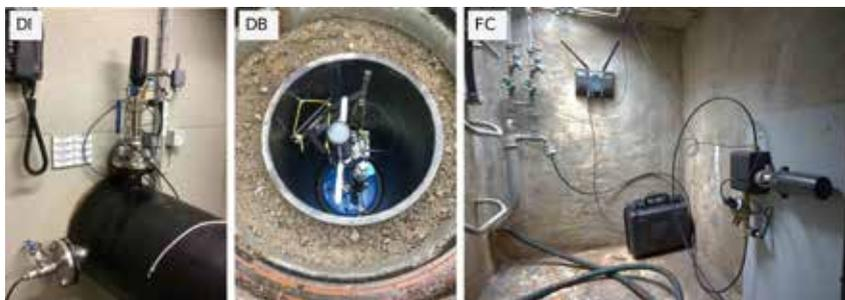
**Bild 2:** Fotos der drei installierten Sensortypen zur Messung der Wasserqualität. Direct Insertion (DI) zur Installation in begehbaren Schächten, Direct Bayonet (DB) zur direkten Installation in der Trinkwasserleitung in Minischächten im Strassenraum und Flow Cell (FC) zur Bypass-Messung in Anschlusschächten von Trinkwasserbrunnen.
