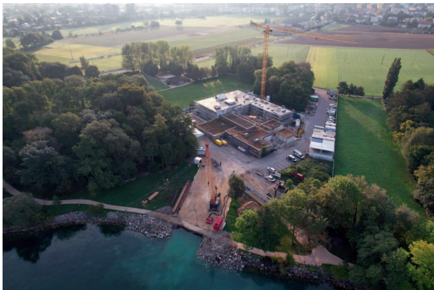
Abb. 1: Drohnenansicht der Baustelle des Seewasserwerks Ipsach. Datum: 01.10.2022
