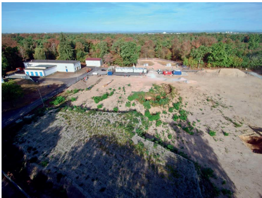
Abb. 4: Juli 2018: Die Netzpumpenhalle und die Halle der Notstromersatzanlage (rote Dacheindeckung) des Bestandswerkes links im Bild, in der Bildmitte die Baustelleneinrichtungsfläche und die Baucontainer, dahinter die bereits ausgehobenen Versickerungsbecken.
