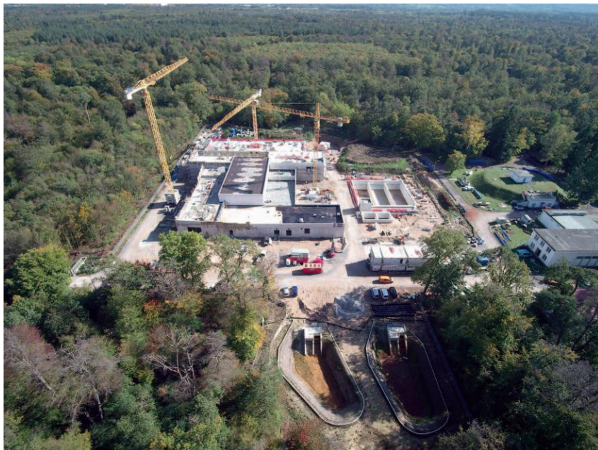
Abb. 5: Ende 2019 waren die Rohrleitungs- und Rohbauarbeiten nahezu fertiggestellt.
