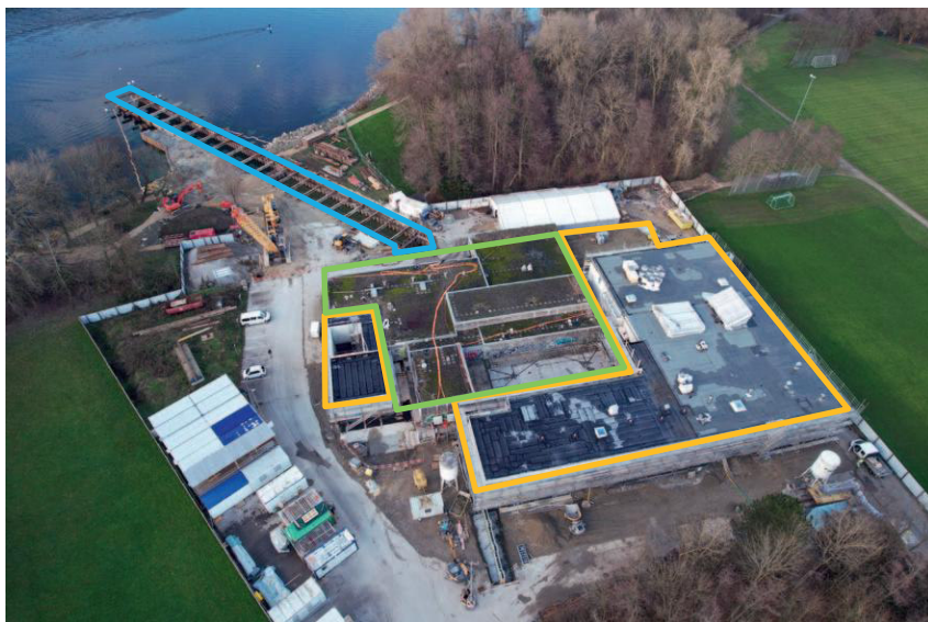
Abb. 5: Baustelle des neuen Seewasserwerks am 20.12.2022. In grün ist das bestehende Werk markiert. In gelb die Bauphase 1. Ein Teil des bestehenden Werkes musste in der Bauphase 1 bereits stillgelegt werden, damit dort die Schwemmwasseraufbereitung des neuen Werks realisiert werden konnte. Der oberirdische Teil des bestehenden Werks wird in der Bauphase 2 rückgebaut und die zweite Hälfte des neuen Werks an dieser Stelle errichtet. Blau markiert ist der Korridor der zwei neuen 750 m langen Rohwasserleitungen.
